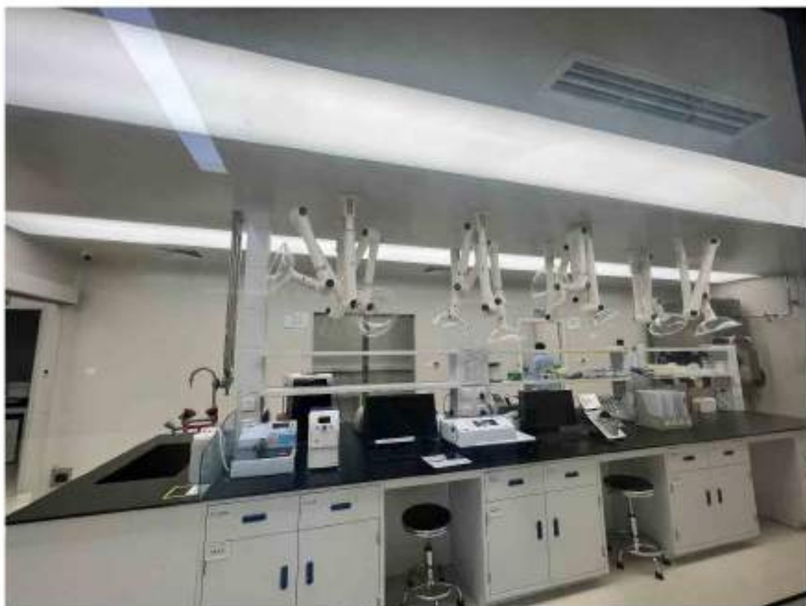
QC 实验室废气收集系统
