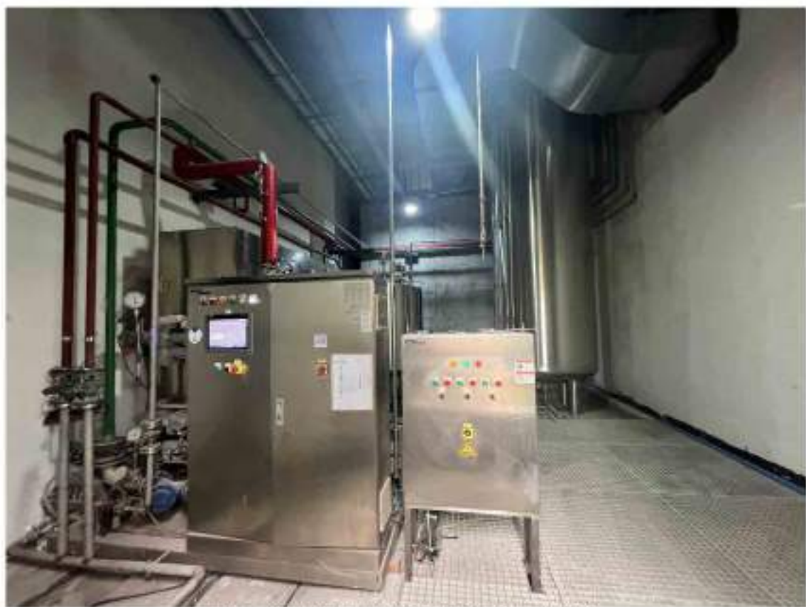
废水高温蒸汽灭菌装置及生化处理设施
