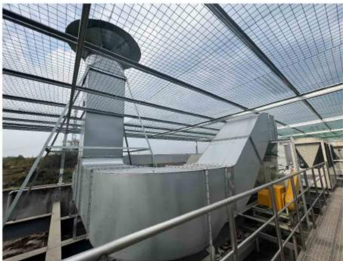
动物房臭气处理系统（活性炭吸附装置+高效过滤器）及排气筒
