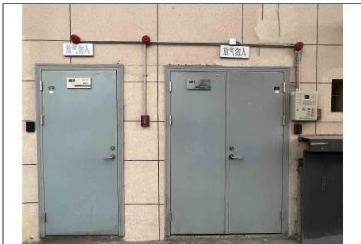
柴油发电机房气体灭火系统
