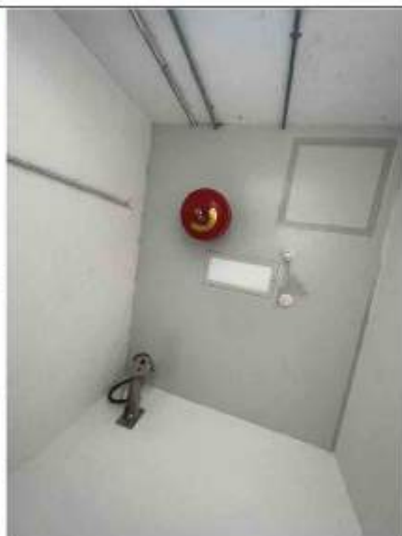
有毒有害物质泄漏检测仪及灭火系统
