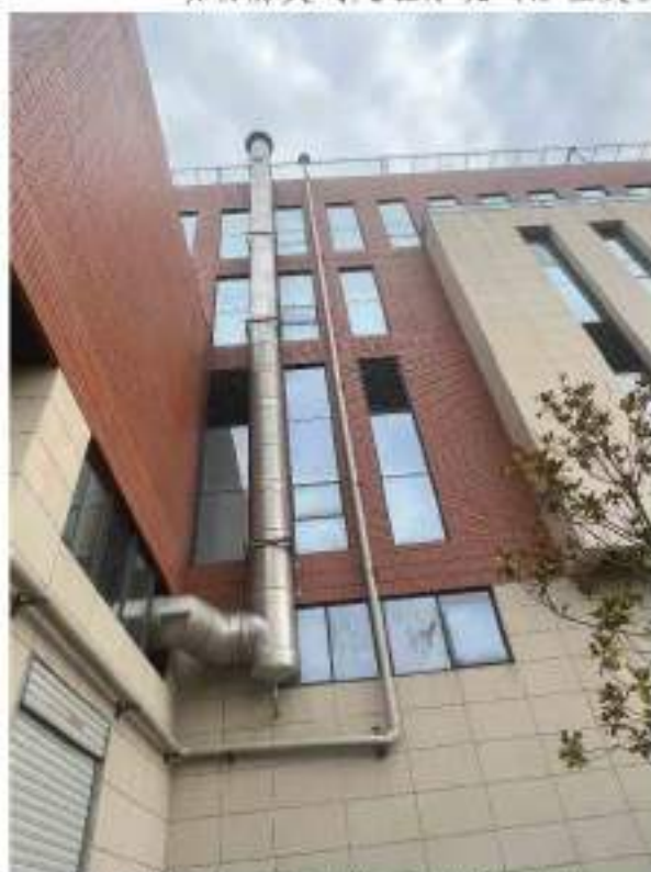
锅炉燃烧废气及污水处理站臭气排气筒
