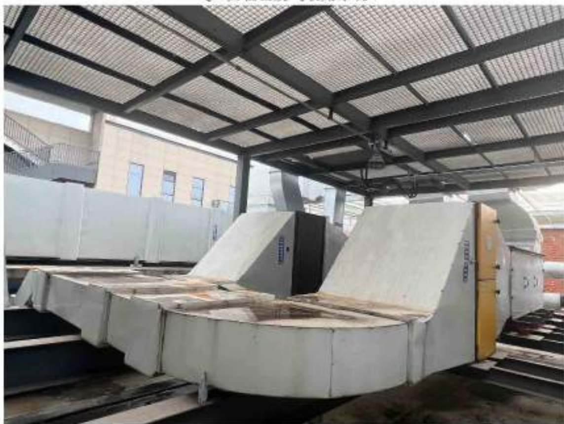
QC 实验室废气处理系统（活性炭吸附装置）
